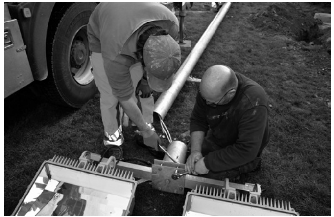
Die Leuchten werden zur Montage auf den Mast vorbereitet
