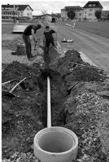
Die Kunststoffrohre für die Elektrischen Leitungen und die Abzweigschächte sind verlegt, die Gräben werden zugeschüttet
