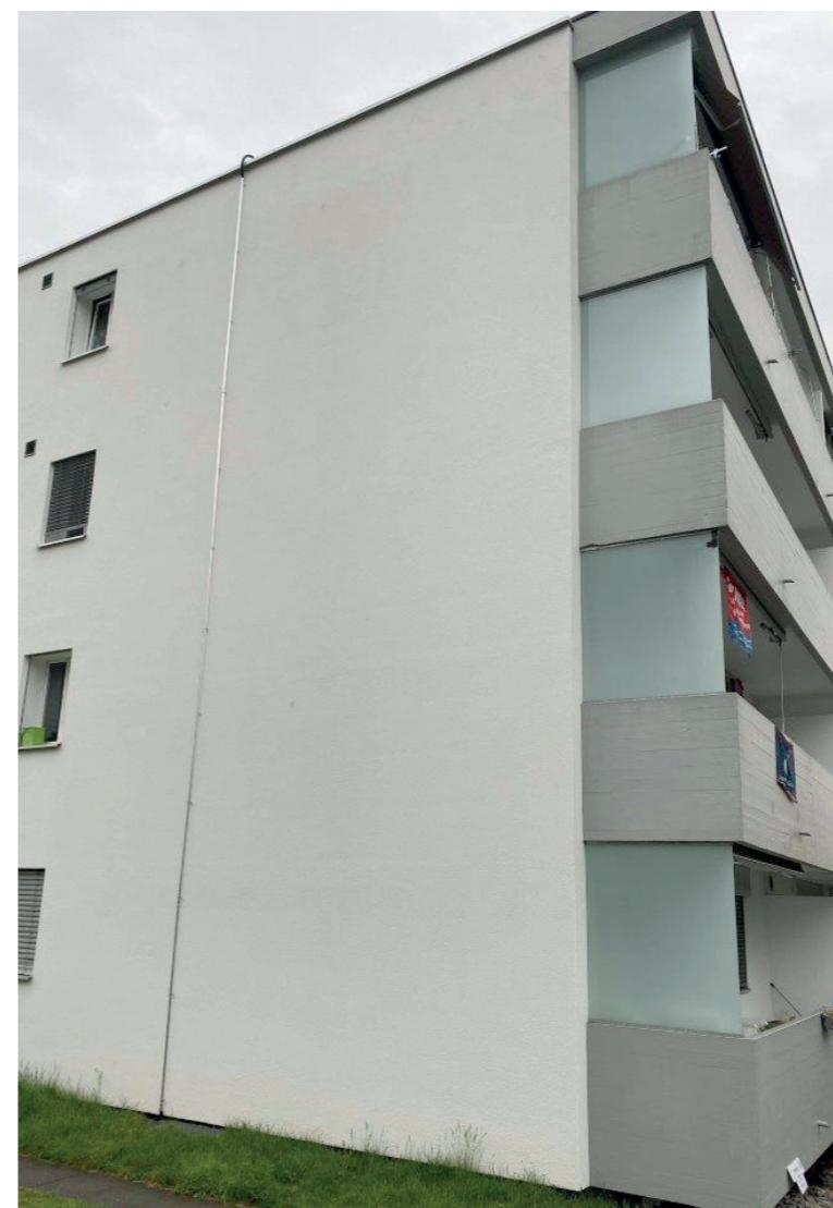
Durch einen Zusammenschluss zum Eigenverbrauch kann Solarstrom vom eigenen Dach an die Mieter verkauft werden – wie bei diesem Mehrfamilienhaus in Moosseedorf.
